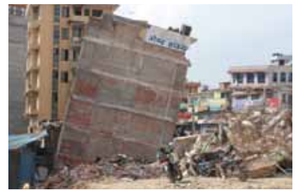
耐震不足・施工欠陥が浮き彫りに(カトマンズ)
