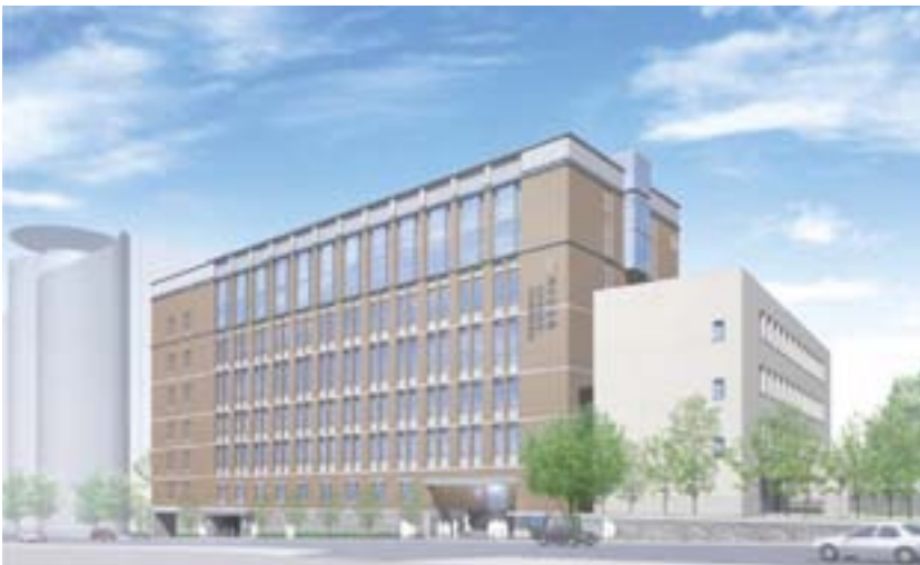
平成20年完成予定 新校舎
